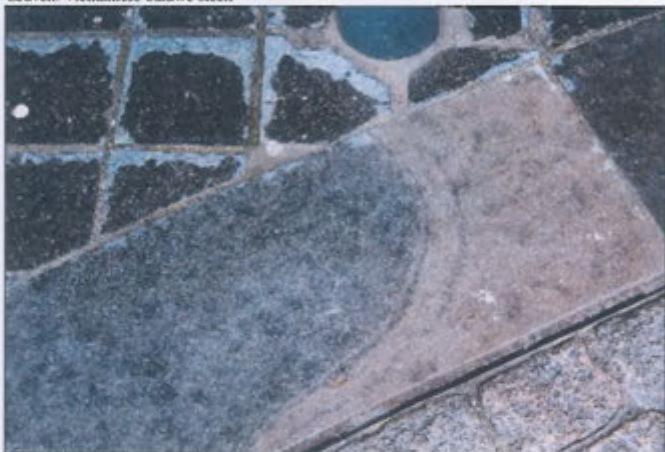
Beige verkleuring van boordsteen (Petit Granit) met karakteristiek dolomitatiefront. Hasselt
