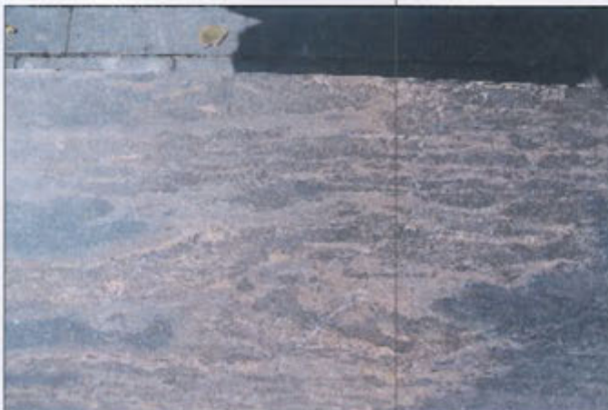
Beige tot bruine verkleurde Chinese blauwe hardsteen. Brussel. De verkleuring loopt parallel met de laagheid en met (open?) zwarte voegen (stylolieten)
