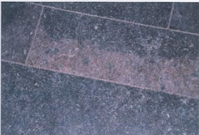
Beige tot bruine verkleuring van gezoete vloertegel (ingang ziekenhuis, Hasselt). Allicht speelt het gebruik van agressieve schoonmaakproducten een rol bij de oxidatie van pyriet
