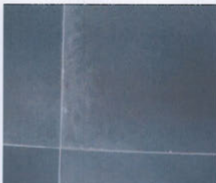
Fig. 8 Krasvorming in een keramische tegel.
