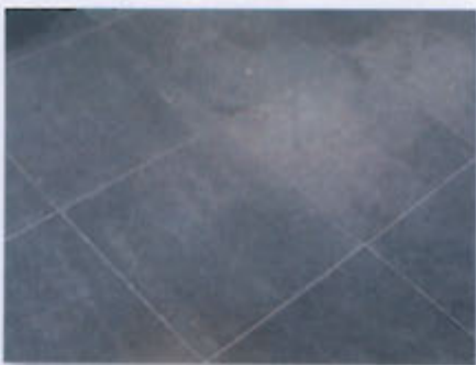
Afb. 3 Slijtage van een keramische tegelvloer.
